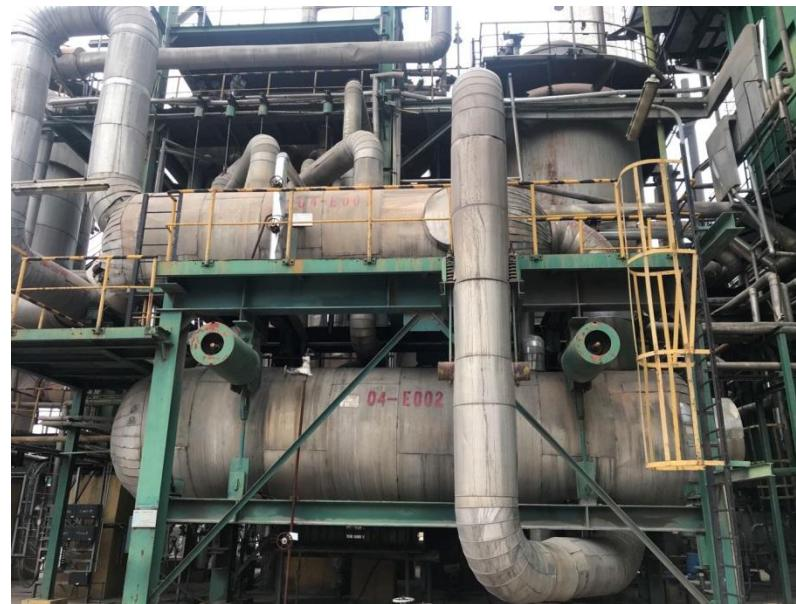
■依托新疆天运30万吨/年合成氨高压转化废热锅炉、中原大化30万吨/年合成氨高压变换废热锅炉项目，进行30万吨/年合成氨热能回收成套装备技术的国产化攻关。
